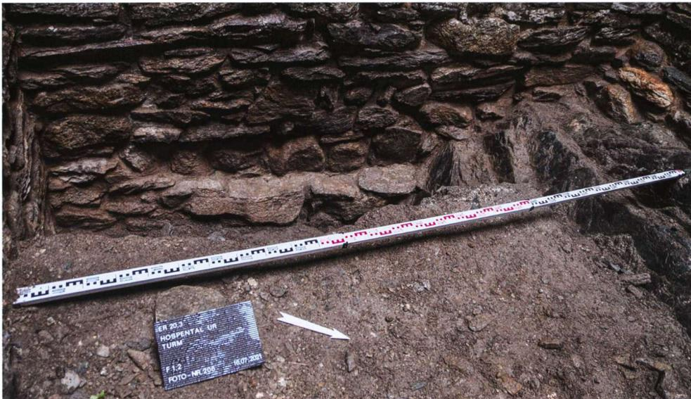
16: Hospental UR, Turm 2021. Übersicht des inneren Fundamentfusses von M4 (F1.2) mit steil abfallender Felskuppe (rechts), 1. Niveau, stufenartigen Absätze im Felsen, 2. Niveau mit Fundamentabsatz. Das 3. Niveau liegt unter der Aufschüttung verborgen. Blickrichtung West.
